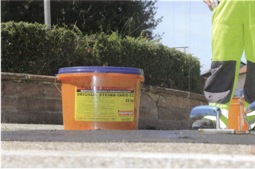
Bei Steiwa-Vario 0/2 und 0/4 handelt es sich um Reaktivasphalt, der durch die Zugabe von Wasser aushärtet.
