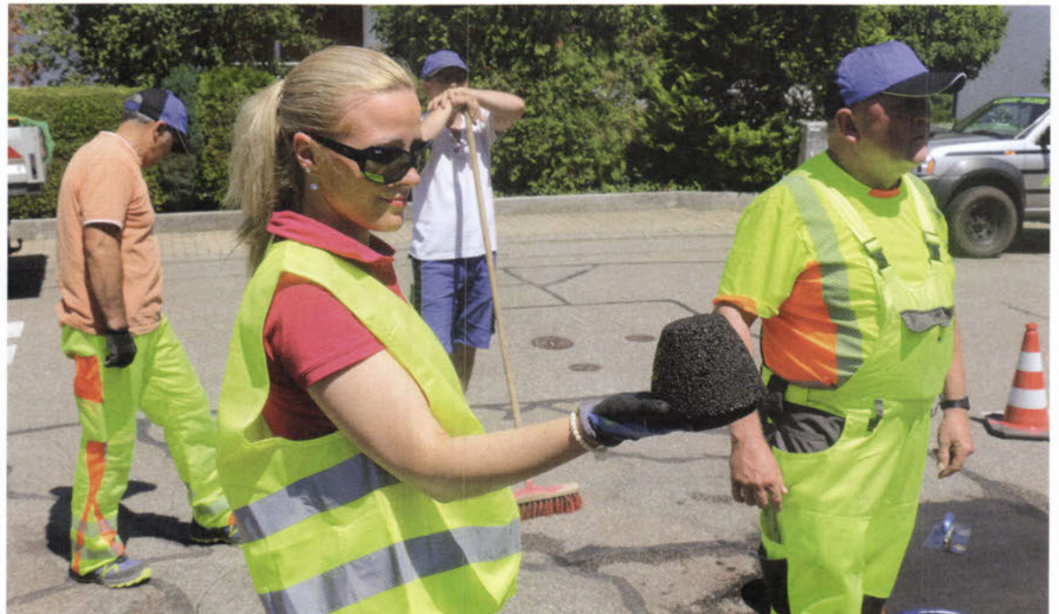
Michaela Steining: Der Reaktivasphalt erreicht bereits zwei Stunden nach Einbau 5,7 kN Druckbelastung. (Quelle DAV/hin)
